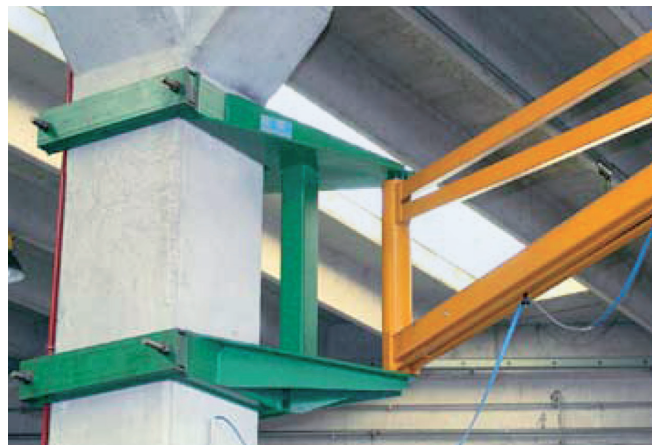
Imbragatura su spigolo. Edge anchoring.
